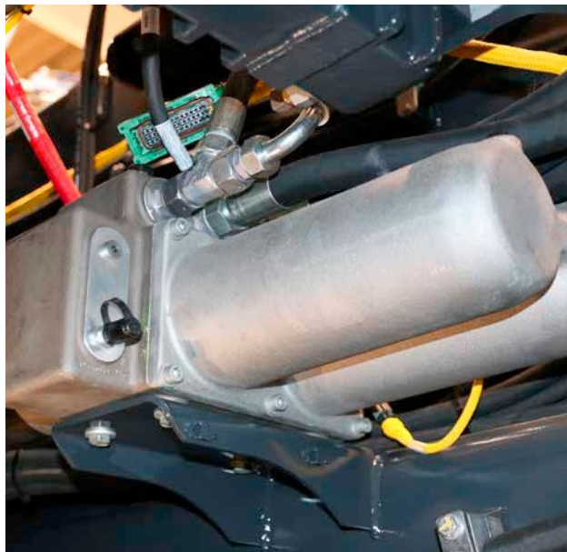
Control electrónico del filtro de retorno hidráulico.
