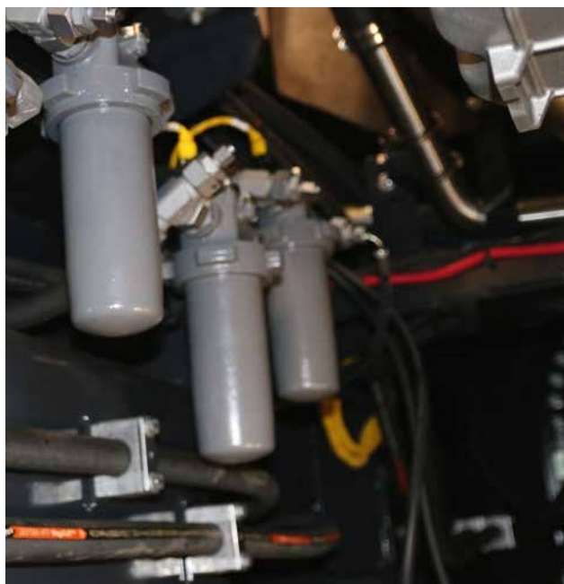
Sistema de filtrado hidráulico.
